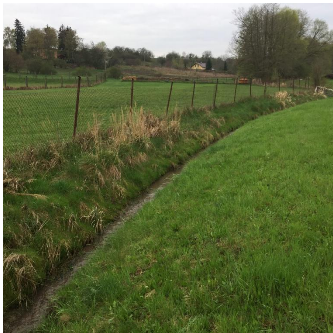
Sulevický potok - před vyčištěním
