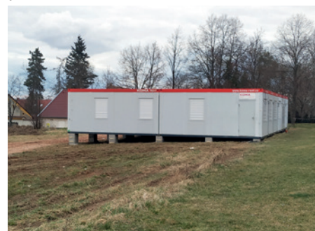
Celý objekt je smontován z celkem jedenácti kontejnerů umístěných na připravené základové patky.
