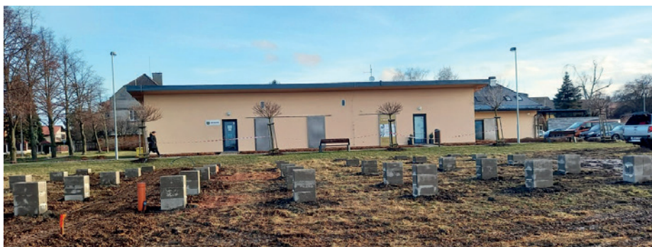
Připrava na osazení modulů v prostoru mezi komunitním centrem a plánovaným volnočasovým centrem. Foto: archiv OÚ Hostouň
