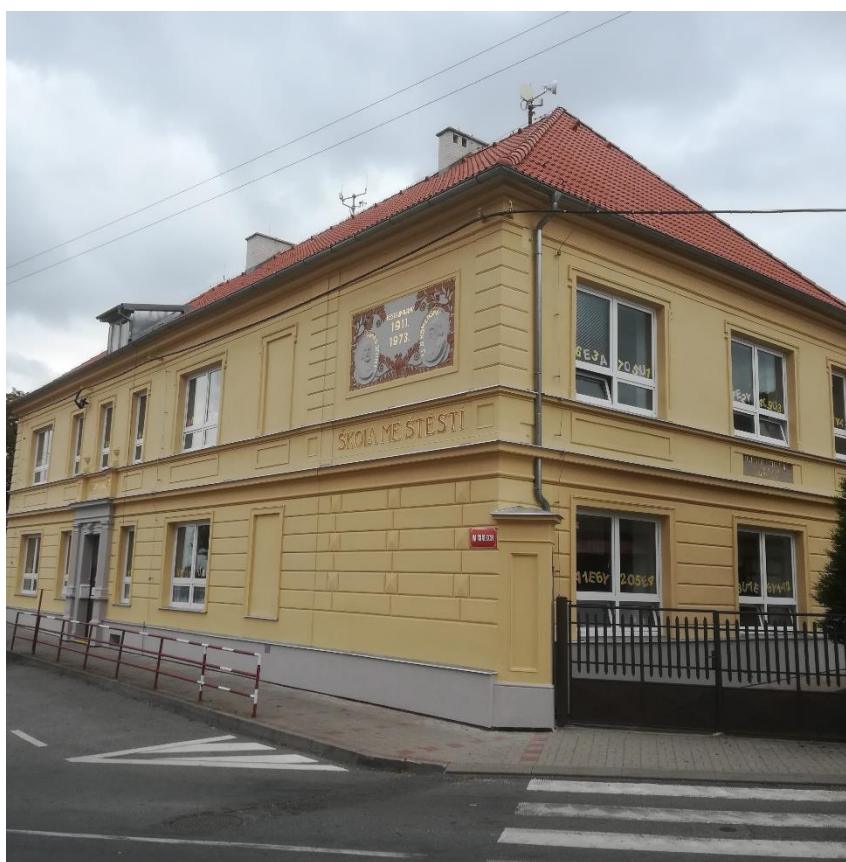
Základní škola po rekonstrukci fasády
