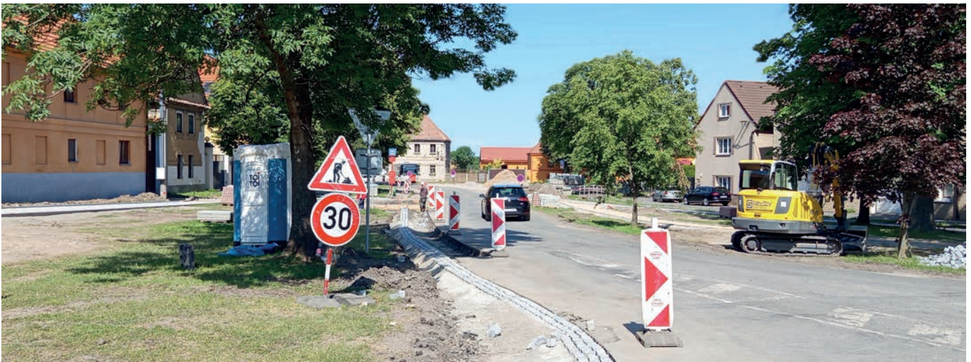
Na Posvícenské návsi probíhají stavební práce.
