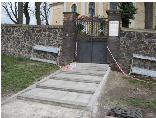
Schody ke kostelu Sv. Bartoloměje
